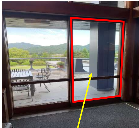
コーティングした窓ガラス面
