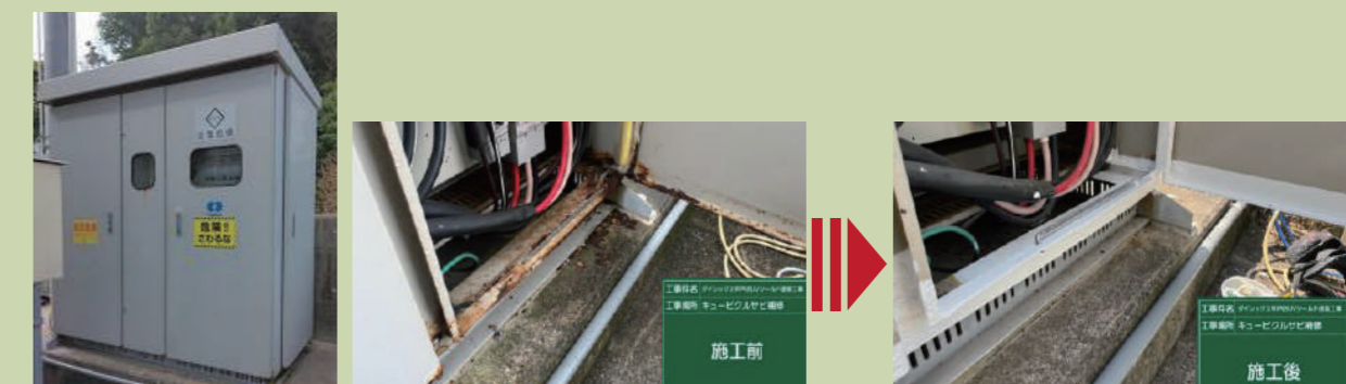
2025年6月、長崎県の海沿い某スーパーキュービクル内防さび対策で塗布
