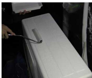
スーパーガラスバリア施工
