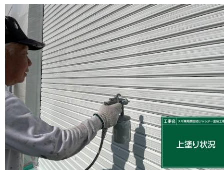
2025年5月、大阪某ドラッグストアのシャッター 遮熱対策で塗布
