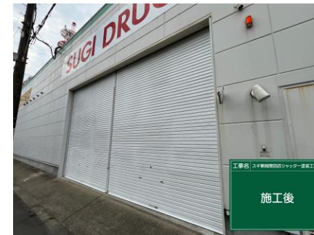
2025年5月、大阪某ドラッグストアのシャッター 遮熱対策で塗布
