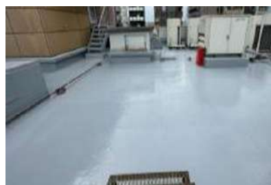
コンクリート陸屋根
