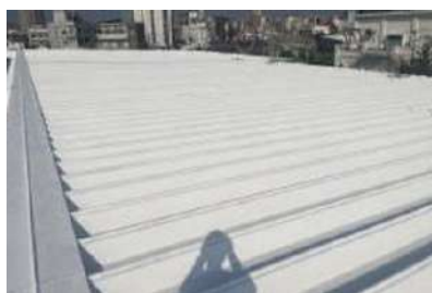
金属折板屋根
