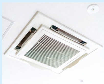
埋め込み式エアコン設置例)
