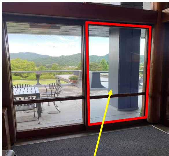
コーティングした窓ガラス面
