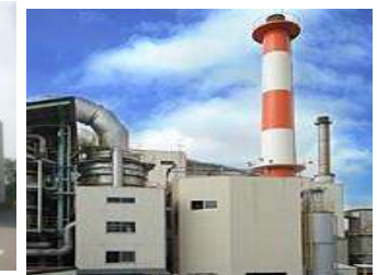
【NRK Clean Center】
