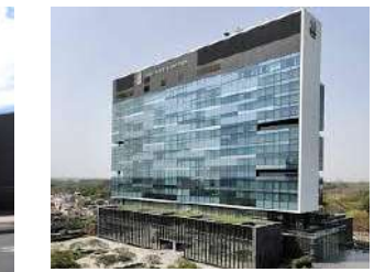
【インド・リッツカールトンホテル】
