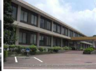
【鹿児島県民総合保健センター】
