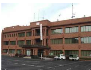
【鹿児島市役所 松元支所】
