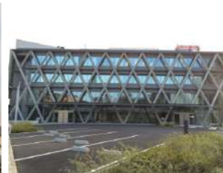
【豊海本社ビル】
