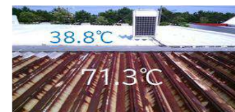
折板屋根断熱塗装あり・なし
