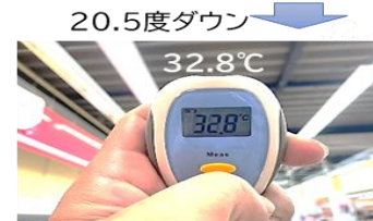
断熱塗装あり室内天井温度
